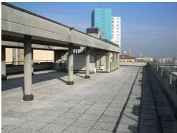
VANI TECNICI IN COPERTURA
