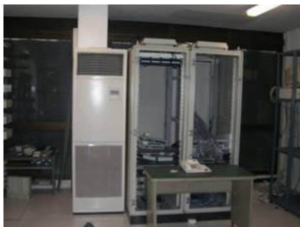
LOCALE SERVER/MAGAZZINO PIANO AMMEZZATO
