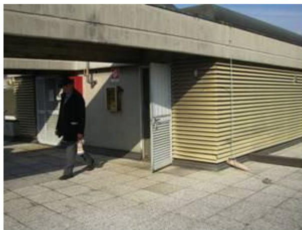
VANI TECNICI IN COPERTURA
