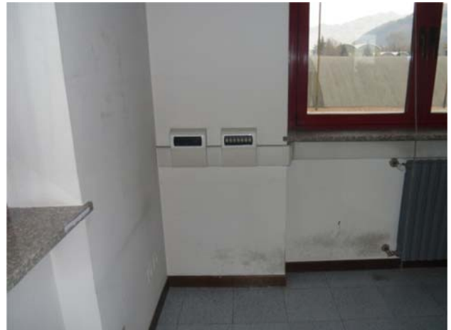
FOTO UFFICIO PIANO PRIMO
